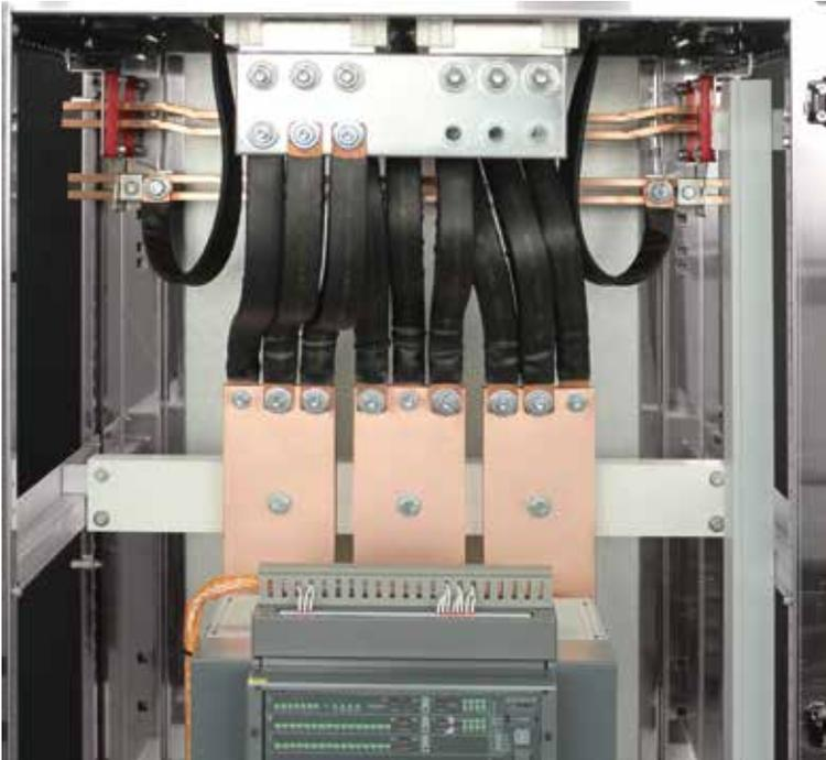
Ultraflexx® zur flexiblen Überbrückung von Schiene auf Leistungsschalter
